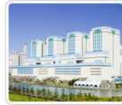
☐ 당진화력본부 설비용량 : 4,000MW 주연료 : 유연탄 위치 : 충청남도 당진군 발전량 : 34,258GWh (2010년 연간 기준)
