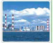
☐ 울산화력본부 설비용량 : 3,000MW 주연료 : 저유황중유, BC유, LNG 위치 : 울산광역시 남구 발전량 : 9,329GWh (2010년 연간 기준)
