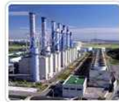
☐ 일산열병합발전처 설비용량 : 900MW 주연료 : LNG 위치 : 경기도 고양시 발전량 : 4,379GWh (2010년 연간 기준)
