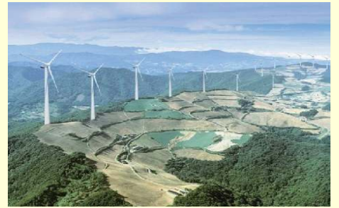
< 대기리 풍력 발전설비 조감도 >
