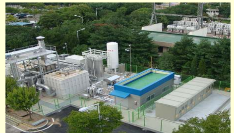
< 일산 연료전지 발전설비 >
