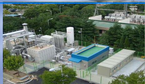
2009. 9 일산 연료전지 발전설비 준공
