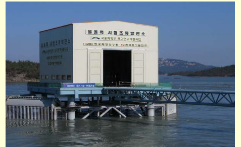
< 울돌목 시험 조류 발전설비 >
