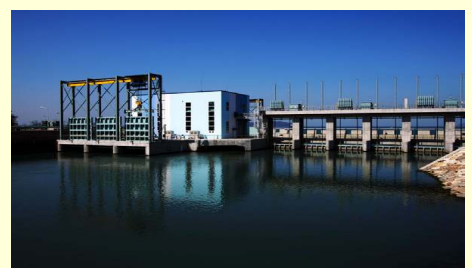
< 당진 소수력 발전설비 >
