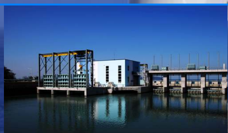
2009. 12 당진 소수력 발전설비 준공
